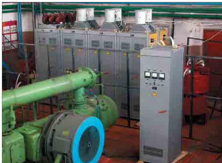
Рис. 1. Преобразователь частоты ПЧ-ТПП-500-6к
